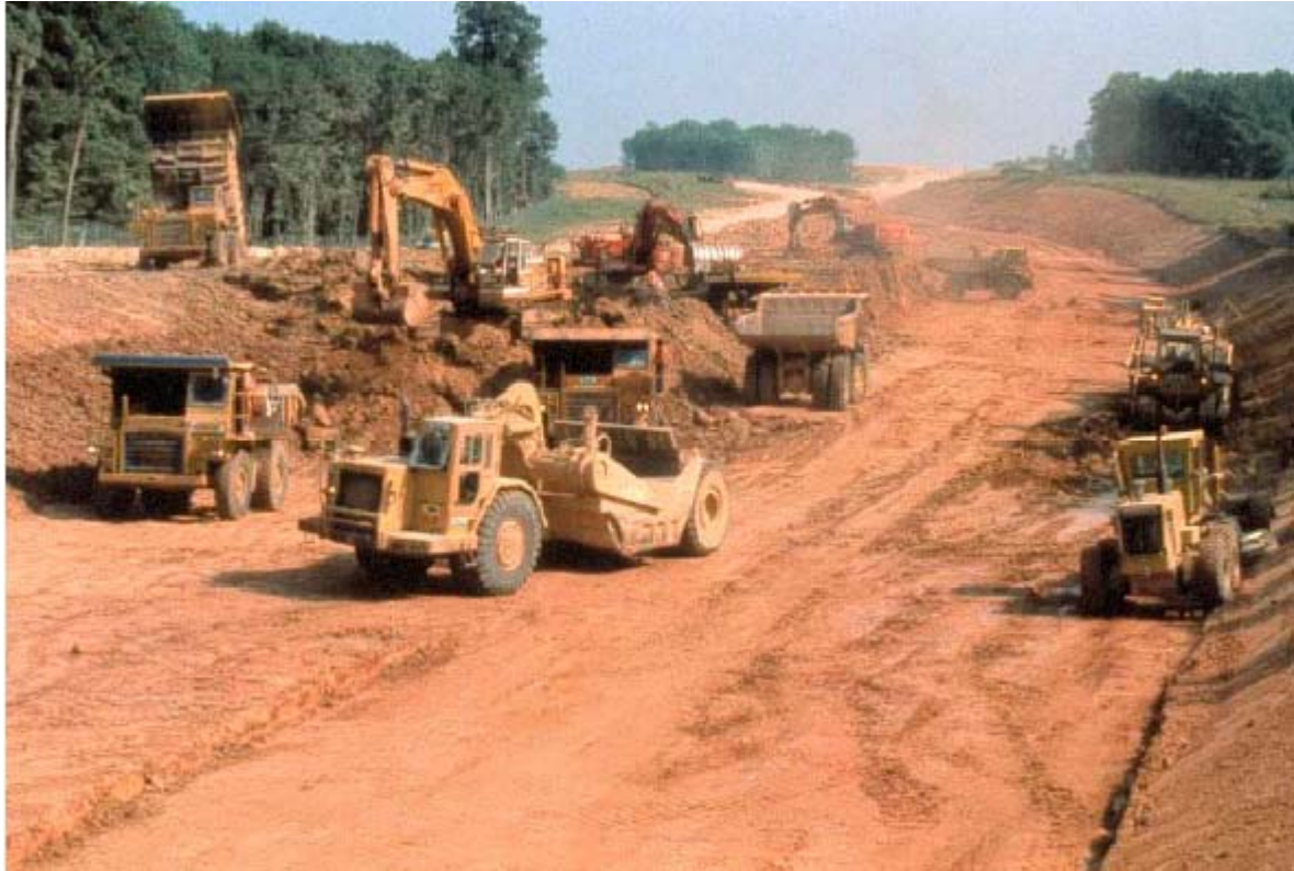
FIG.1 CHANTIER DE TERRASSEMENT AUTOROUTIER
