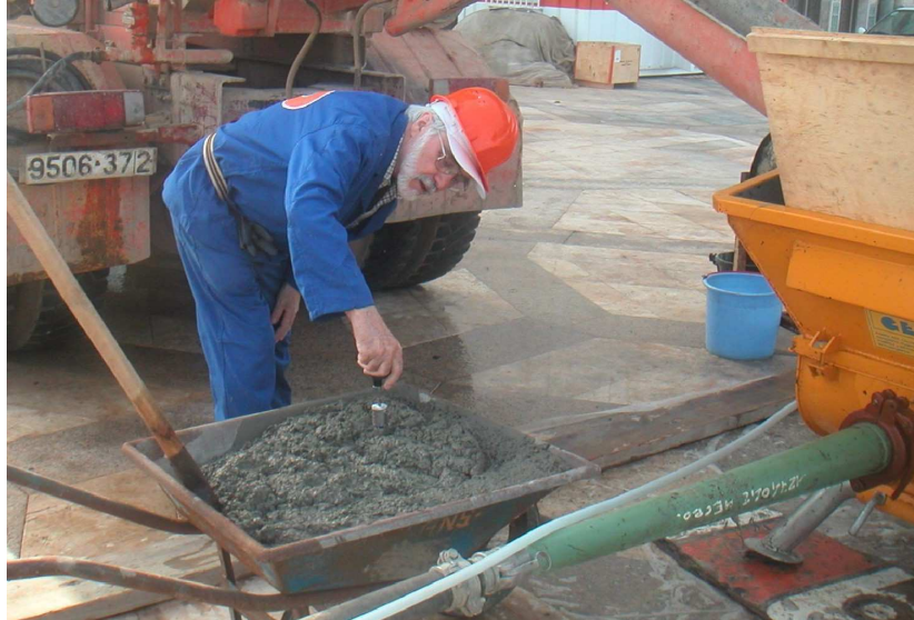
Mesure au « pompabilimètre » de poche, avant de charger la pompe
