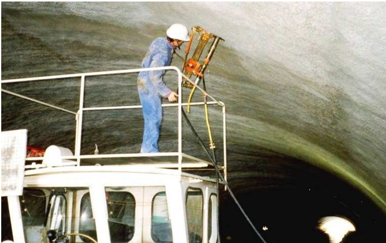
Carottage en voûte pour mesure de l'adhérence du béton projeté au support (NF EN 144888-4)
